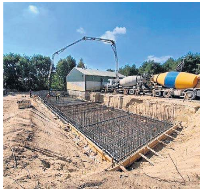
W Kroczowie Większym trwa rozbudowa i modernizacja oczyszczalni ścieków.
