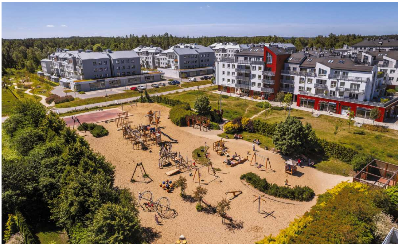
Zrealizowane przez Grupę Inwestycyjną Hossa osiedle Wiczlino-Ogród w Gdyni.
