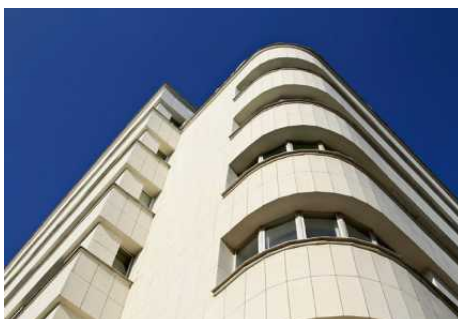
• Kamienica przy ulicy Świętojańskiej 68
