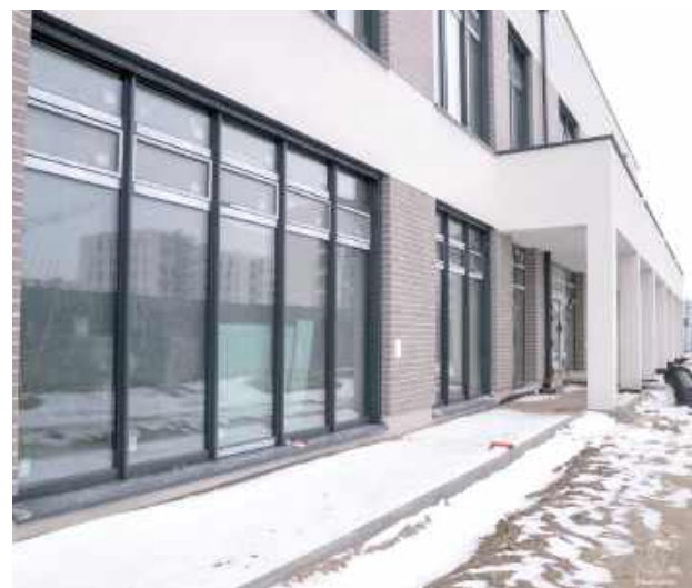
Już widać ładną ceglana elewację nowego żłobka
