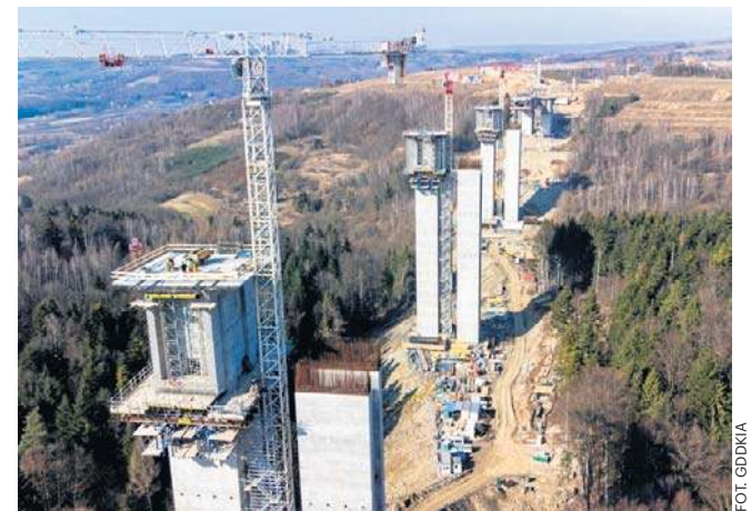
Najwyższy filar estakady na odcinku S19 Babica-Jawornik osiągnął 80 metrów wysokości
