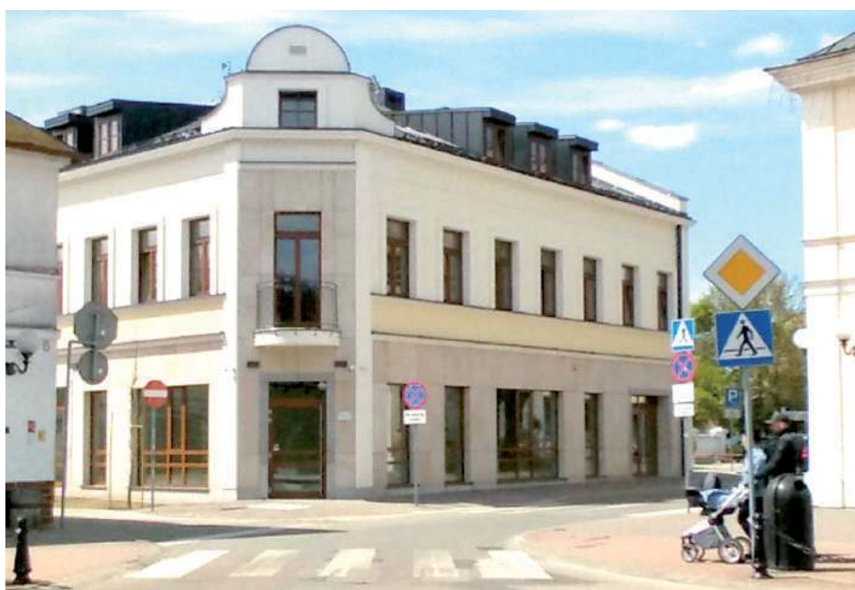
Dzięki temu, że w 2022 r. nie zakończono budowy kamieniczki przy ul. Krótkiej, zaplanowany olbrzymi deficyt został ograniczony do prawie 43 mln zł...
