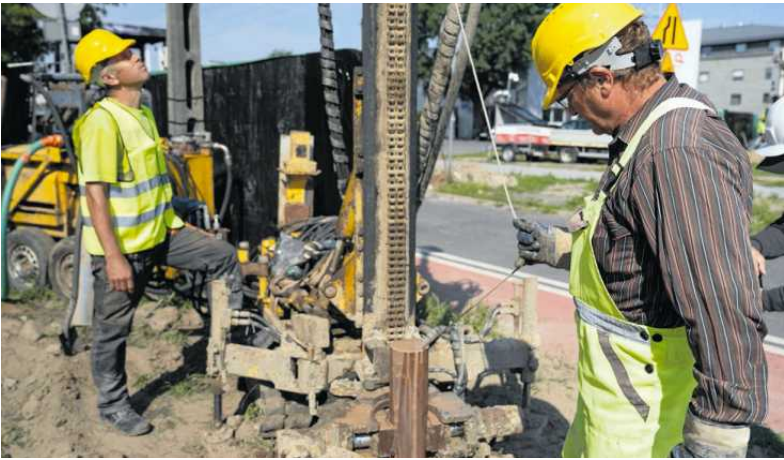
• Odwierty geologiczne na Białolekę FOT. MATERIAŁY INWESTORA
