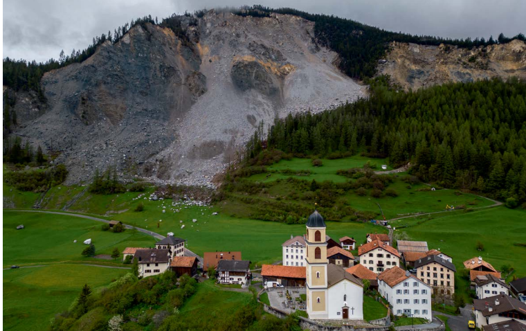
Brienz w Szwajcarii zostało ewakuowane w 2023 r. z powodu zagrożenia osuwiskami. Mieszkańcom zakazano powrotu.
