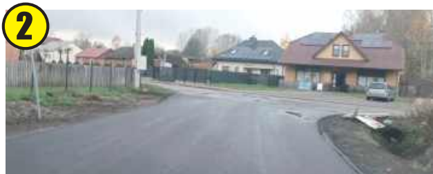
Przebudowa drogi Pustelnia - Trzebieszka - Darowne na odcinku Trzebieszka - Darowne (dł. 1,170 km)
