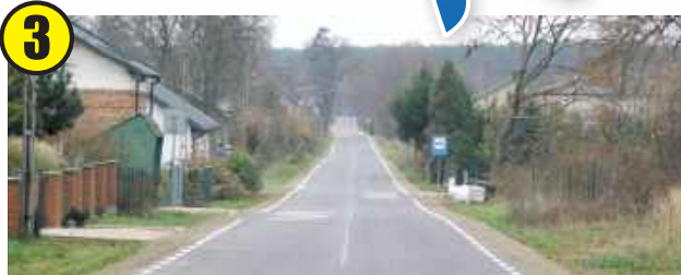
Przebudowa drogi Leonin - Wandalin na odcinkach Skoków - Leonin - Stary Franciszków (dł. 3,817 km)
