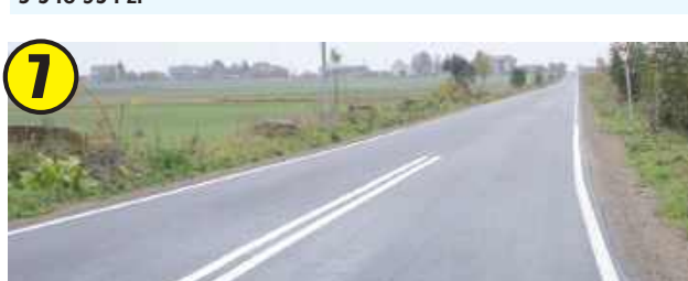
Przebudowa drogi Komasyce - Puszn Godowskie w miejscowości Truszków (dł. 755 m)
