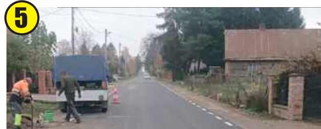
Przebudowa drogi Karczmiska - Wymysłów - Kolonia Niezabitów na odcinku Wymysłów - Kolonia Niezabitów (dł. 3,910 km)
