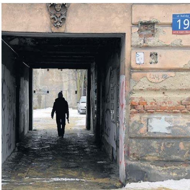
W kamienicy przy ul. Kaliskiej zmarły dwie osoby
