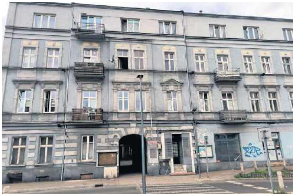
Podstudio Polskiego Radia w Katowicach mieściło się w sklepie firmowym Elektrowni w kamienicy na rogu ulic Dęblińskiej i Piłsudskiego w Sosnowcu
