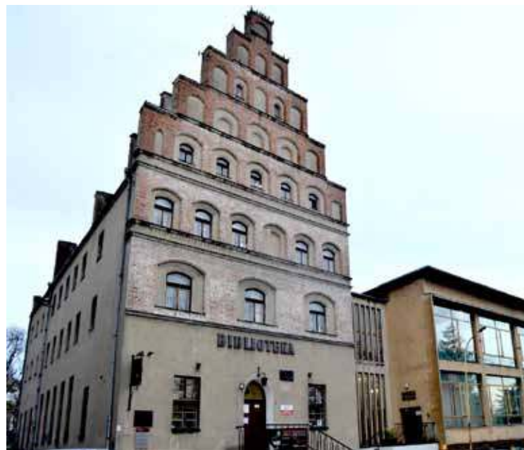
Od 1.03 placówka przy ul. Mieszka I przestanie udostępniać zbiory. Sytuacja spowodowana jest przygotowaniami do remontu
