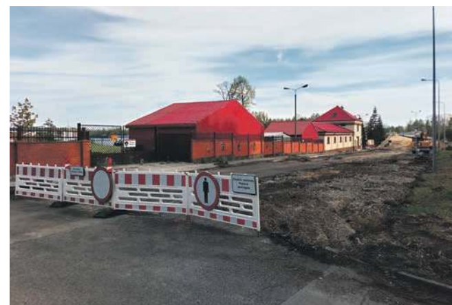
Wskutek prac ziemnych na kilka dni zostanie zamknięty przejazd przez tzw. bajpas od strony centrum Trzebini do Piły Kościeleckiej
