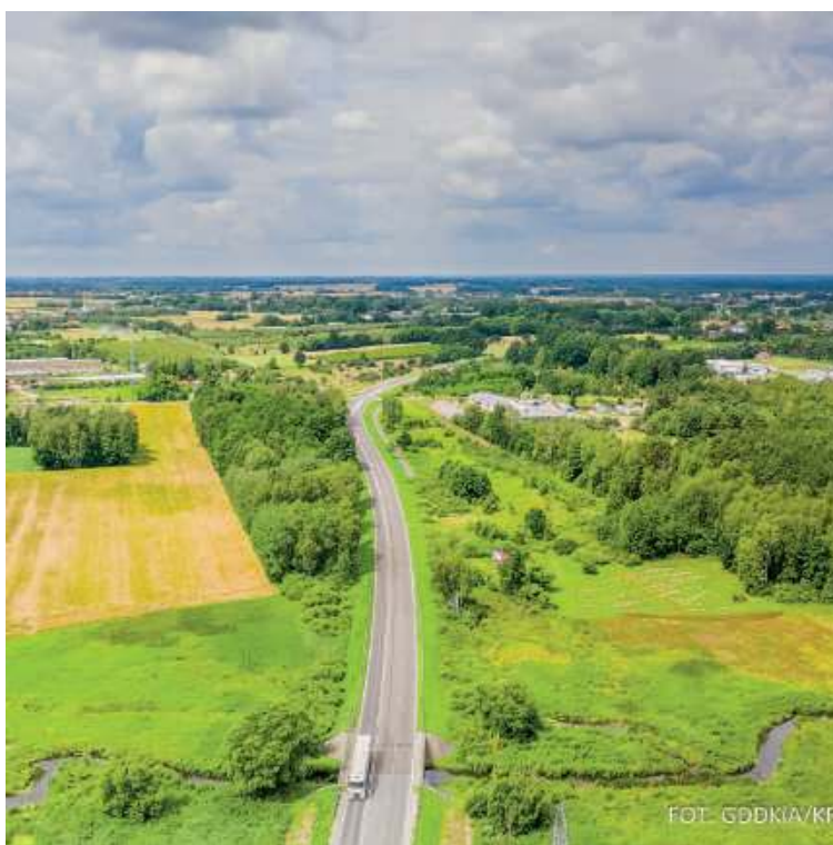
Autostrada A2 za Siedlcami | fot. mat. pras./d
