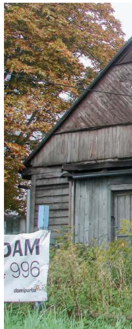
Drewniak przy ul. Ruchliwej 10/12 i fragment wschodniej ściany
