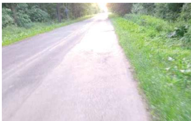
Wyremontowany może zostać m.in. odcinek dawnej DW818 z Kodeńca do Lubiczyna
