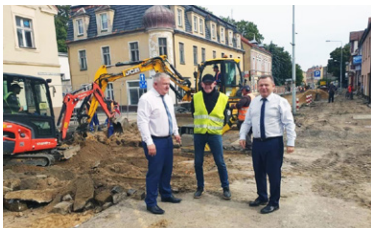
Wołów w budowie. W tym roku na inwestycje gmina wyda rekordową kwotę. Na zdjęciu burmistrz Dariusz Chmura i jego zastępca, Jan Janas na placu budowy.
