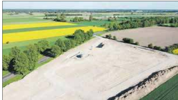
Przy drodze wojewódzkiej nr 811 w miejscowości Cicibór Duży już teraz przygotowywane jest zaplecze budowlane pod prace, związane z budową autostrady A2. Tam ma powstać węzeł Biała Podlaska (Cicibór)
