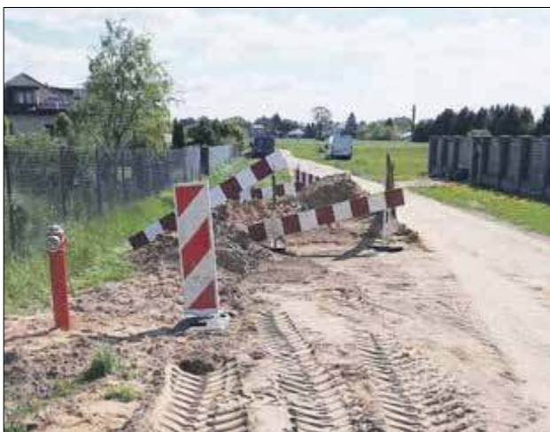
Mieszkańcy uliczki, odchodzącej od ul. Powstania Styczniowego, wreszcie mogą podłączyć się do miejskiej sieci wodociągowej
