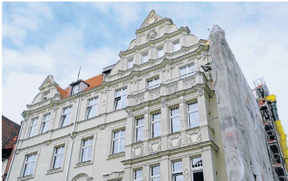
Odrestaurowana kamienica „Pod Kogutem” przy ul. Poniatowskiego 5 to perła dawnego Wilhelmstadt, czyli przedmieścia św. Katarzyny w Toruniu
