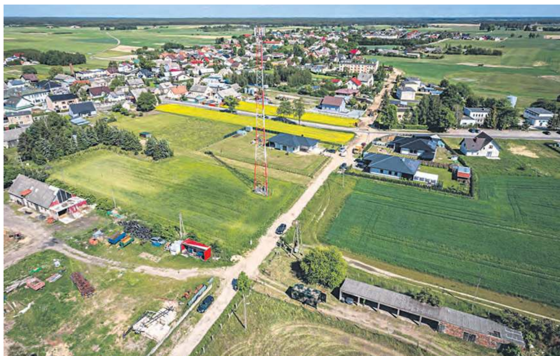
Część Bysławia była zasilana od piątku do niedzieli (3-5 czerwca) przez kontenerową elektrownię polową.
