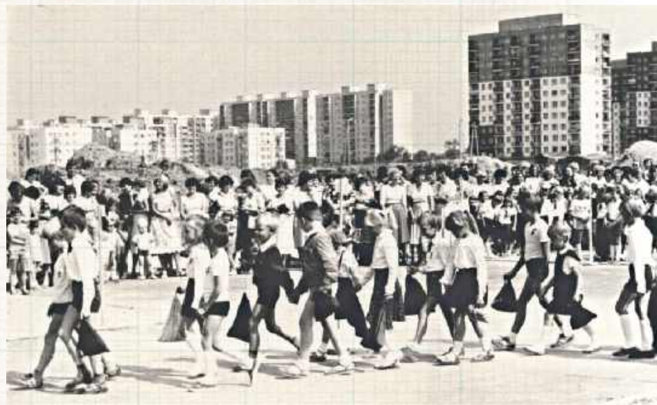
Od końca lat 50. powstały rozległe osiedla bloków z wielkiej płyty, a także obiekty użyteczności publicznej, takie jak szkoły, kościoły, biblioteki czy Szpital Kliniczny nr 4
