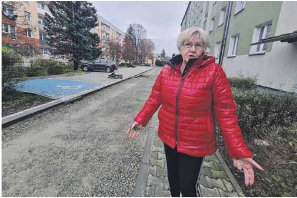
Prace pod blokiem 126b przy ul. Szaflarskiej wloką się już dwa miesiące. - To karygodne - uważa pani Alicja.
