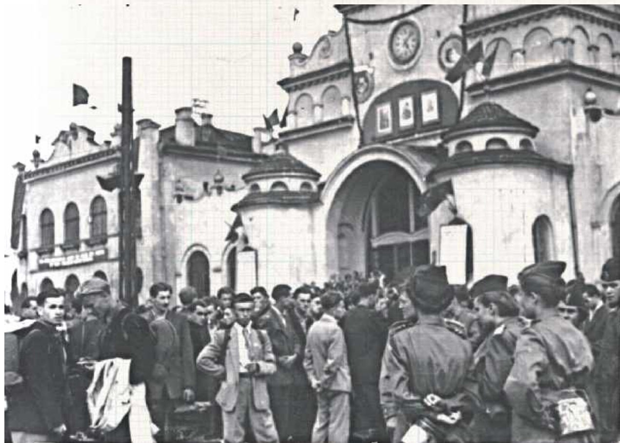
Dworzec Główny PKP, zdjęcie wykonane w latach 1954-1975
