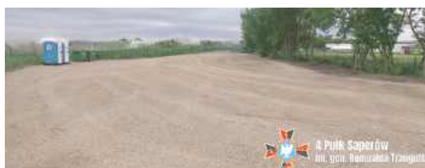
Na zakończenie przeprowadzono częściowe utwardzenie powierzchni parkingu przy użyciu kruszywa, co zapewniło trwałość i funkcjonalność nowej nawierzchni
