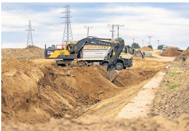
Budowa nowego zbiornika retencyjnego
