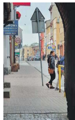
W NML zachowały się mury obronne wybudowane przez Krzyżaków. W mieście są dwie gotyckie baszty bramne. Na zdjęciu Brama Brodnicka. Brama Lubawska po drugiej stronie rynku jest w remoncie
