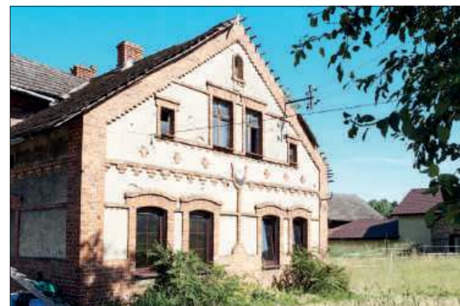
■ Najstarszy budynek w Kobyli z charakterystycznymi ceglanymi nadprożami łukowymi
