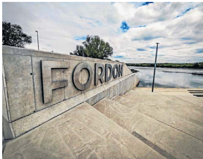
Budowa nabrzeża w Starym Fordonie zakończyła się pod koniec 2022 roku. Kosztowała ponad 8 mln zł
