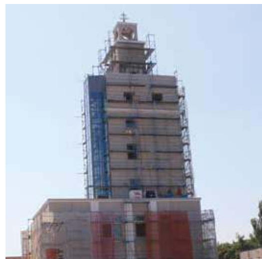
Już można podziwiać nową, kilkudziesięciometrową konstrukcję
