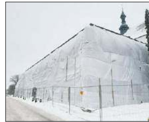
Dotacja została przeznaczona wyłącznie na prace zewnętrzne, które trwają od sześciu lat
