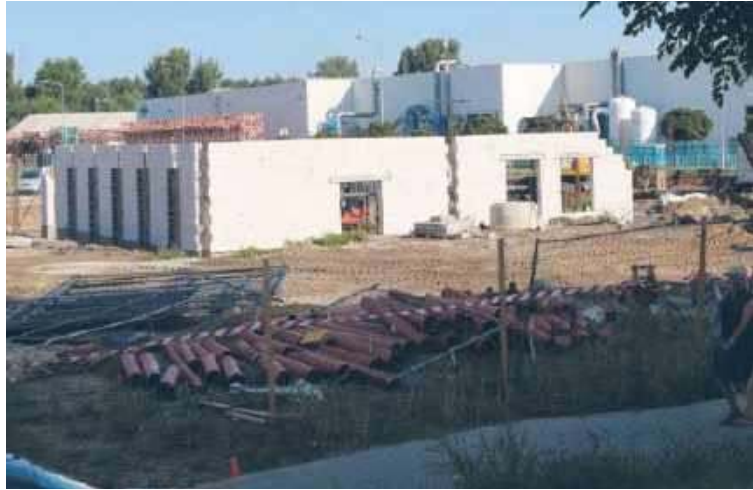
Widać już mury długo wyczekiwanej restauracji (fot. UM Nowa Sól)
