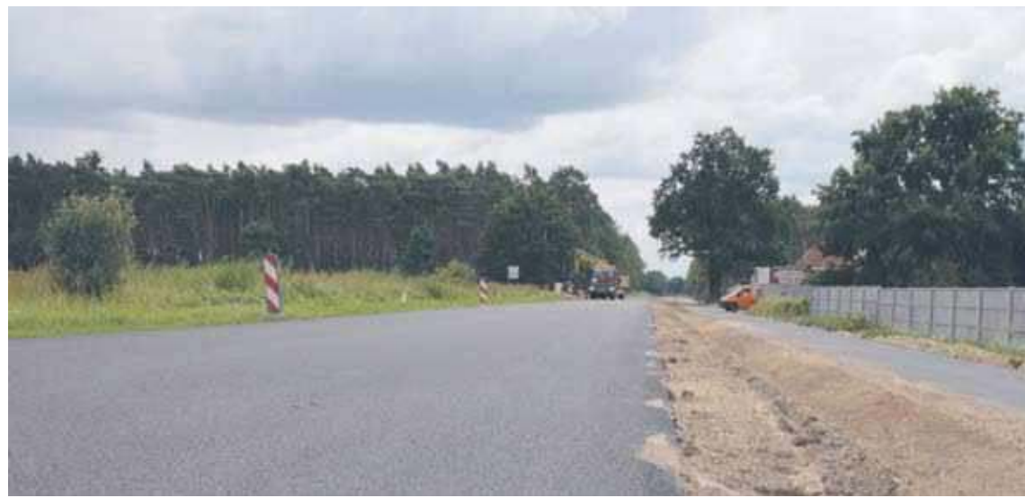
Remont drogi jest na ukończeniu
