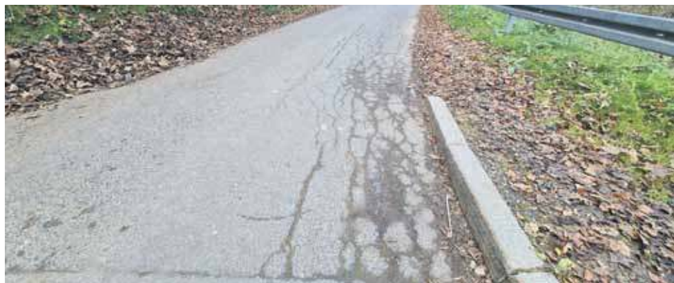
Tak wygląda wyremontowana cztery lata temu droga na Kotelniczy w Zakopanem.
