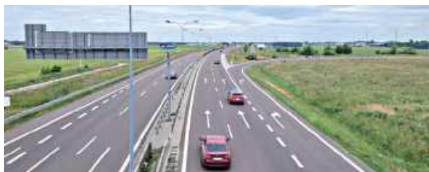
23 czerwca rozpoczął się remont jezdni w kierunku Warszawy na obwodnicy Garwolina w ciągu drogi ekspresowej S17
