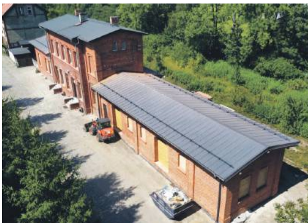
Budynek po byłej stacji kolejowej w Kondratowicach. W ostatnich miesiącach przeprowadzono m.in. remont dachu. Fot. UG Kondratowice
