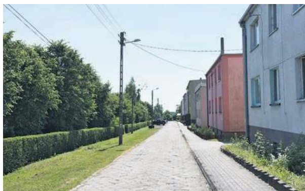
Na osiedlu zostanie przebudowana droga przy blokach.
