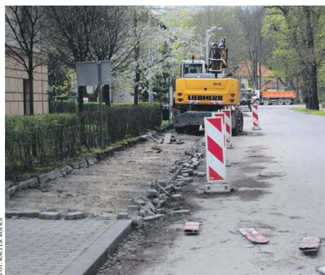
Prace na Ogrodowej w Krzeszowicach
