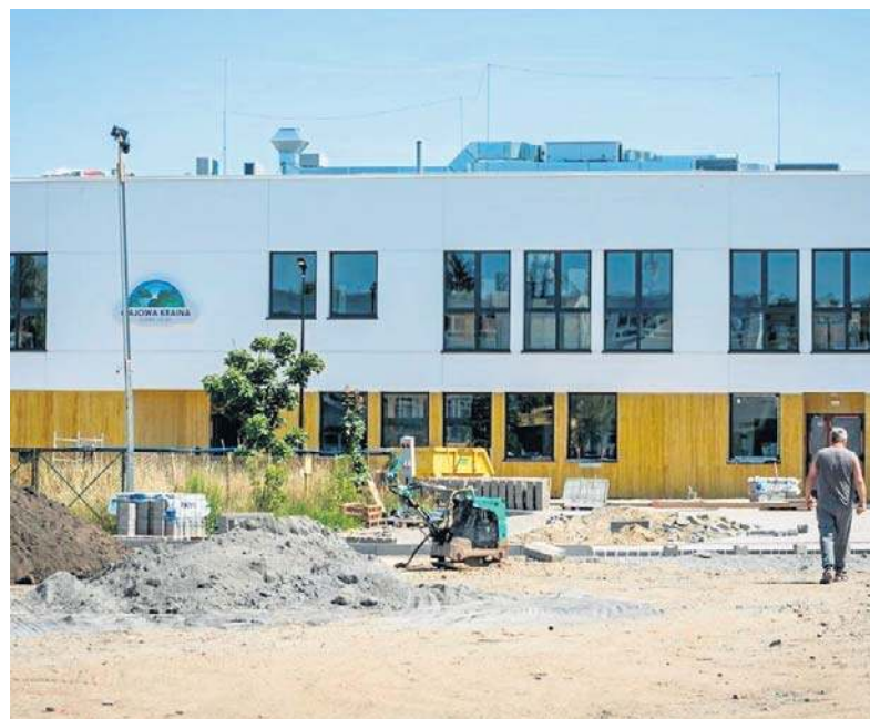
Na budynku zostało już zamontowane logo placówki. Żłobek będzie się nazywał „Gajowa Kraina”. Jeszcze podczas tegorocznych wakacji planowane są odbiory
