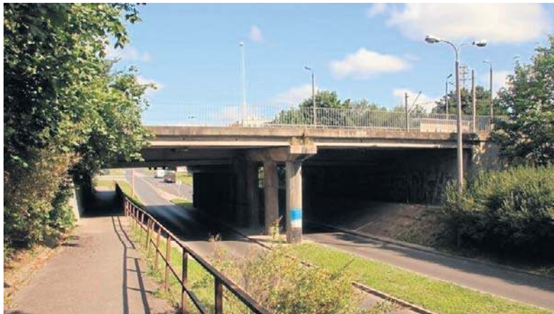
Drogowy wiadukt nad ulicą Brzechwy wybudowano wraz z kolejowym na początku lat 80. XX wieku
