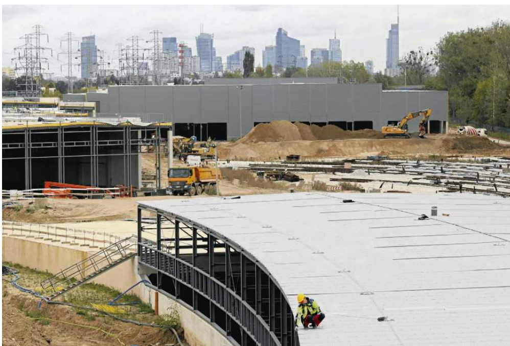
• Budowa stacji metra Karolin
