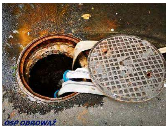
Strażacy przez dwa dni pompowali ścieki do studzienki.
