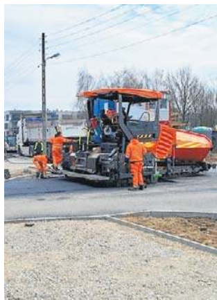
Prace na pierwszym odcinku ulicy Zakładowej są na finiszu
