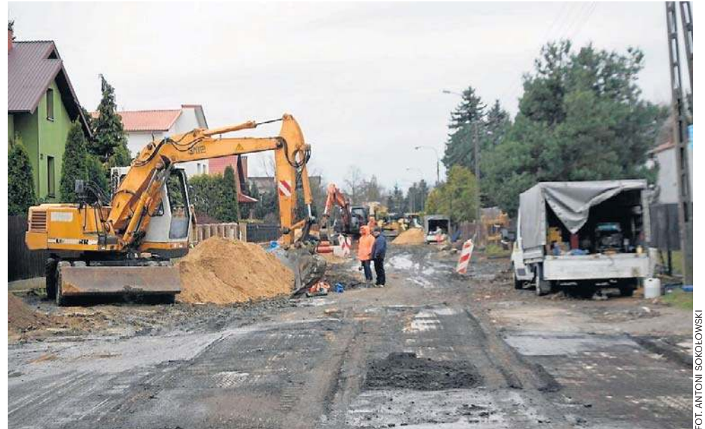
Na przebudowywanej ulicy Idalińskiej w Radomiu obowiązuje zakaz ruchu, z wyjątkiem pojazdów budowy oraz w miarę możliwości, dojazdu do posesji.
