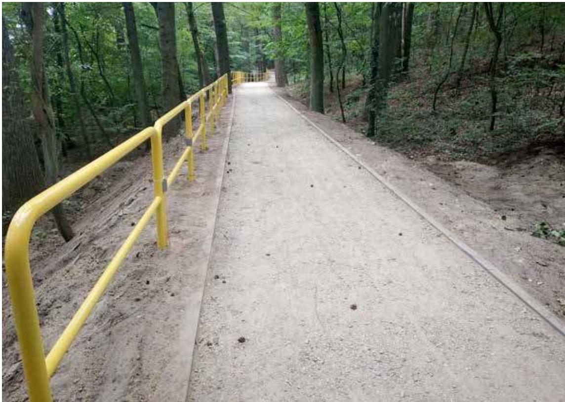
Fragment ścieżki od strony polany harcówki został zabezpieczony barierkami podobnymi do tych umieszczonych już wcześniej z drugiej strony jeziora
