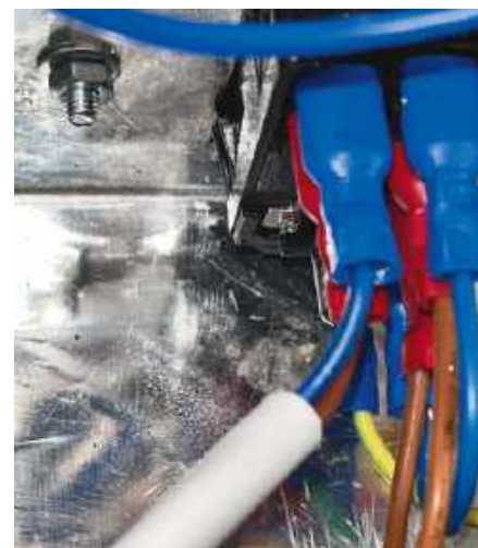
Fotografia 8. Zbliżenie połączeń sieciowych do gniazda wejściowego IEC przed umieszczeniem na nich ochronnej puszkii Jiffy
