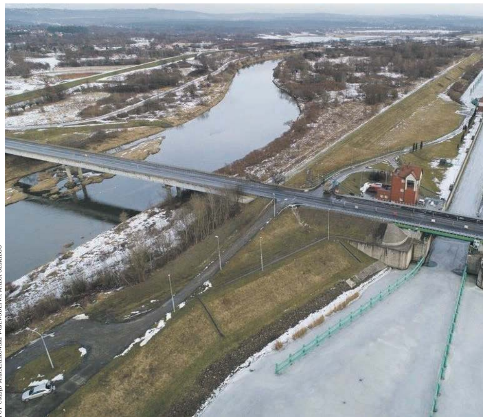
Widok na most nad Wisłą i nad kanałem Smolice
