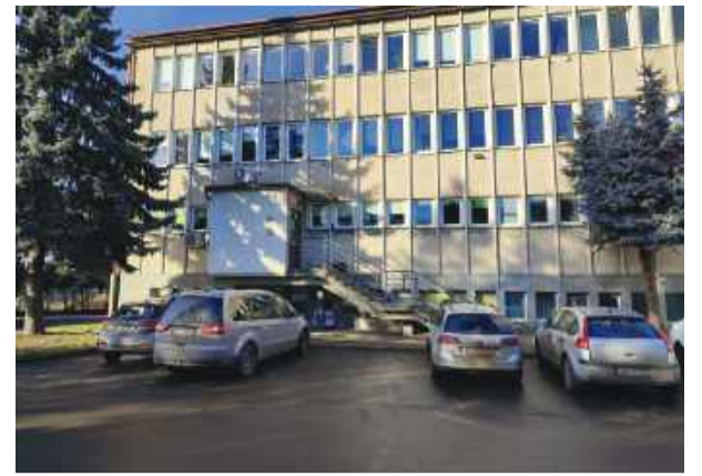
Dokumentomat zainstalowany zostanie obok wejścia do Wydziału Komunikacji
