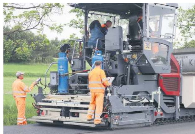
Wyremontowanych zostanie 14 km dróg.
