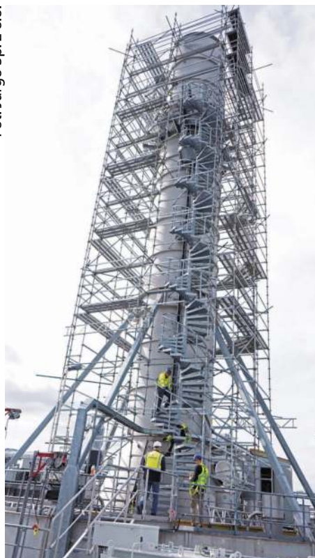
Fot. 2. Rusztowanie wokół stalowego komina o wysokości 50 m i średnicy 3,6 m, przeznaczone do robót spawalniczych
