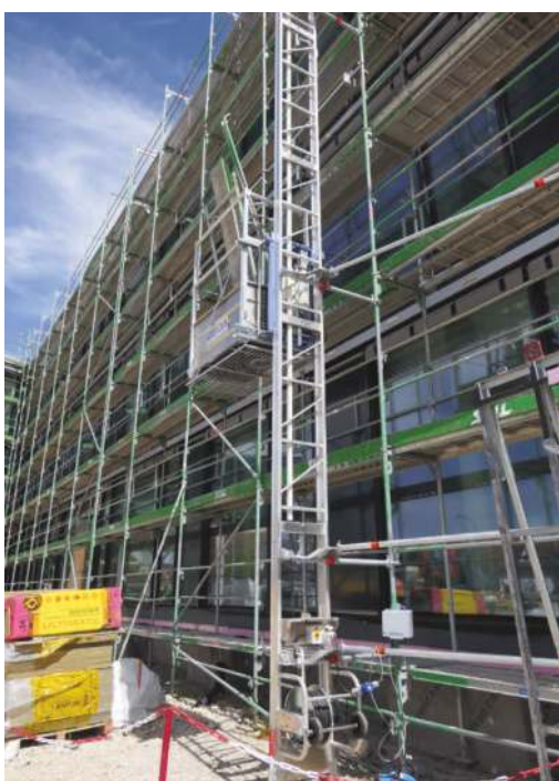
Fot. 3. Dźwig rusztowaniowy GEDA 200Z Comfort
