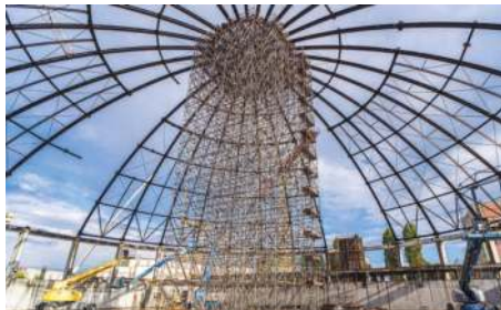
Fot. 5. Rusztowanie dla prac związanych z montażem stalowej kopuły hali widowiskowo - sportowej - Hala Urania w Olsztynie
