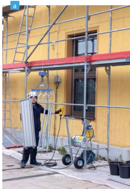
Fot. 1. Wciągarki linowe GEDA : a) Mini 60S, b) Maxi 120S
