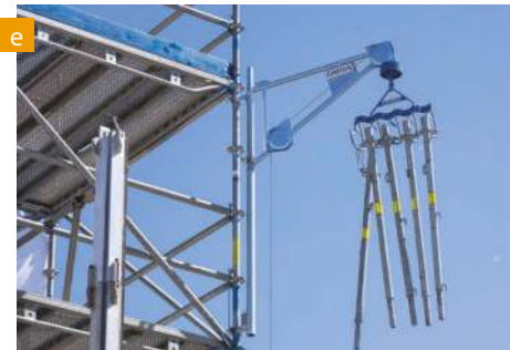
Fot. 5. Pokazy w trakcie III edycji BMR: a) ewakuacja uszkodzonego z rusztowania, b) przeciążenie pomostów rusztowaniowych, c) badanie pomostów przy obciążeniu spadającą masą, d) pomiar wytrzymałości kotwienia, e) sposób działania urządzeń transportu pionowego na rusztowaniach
