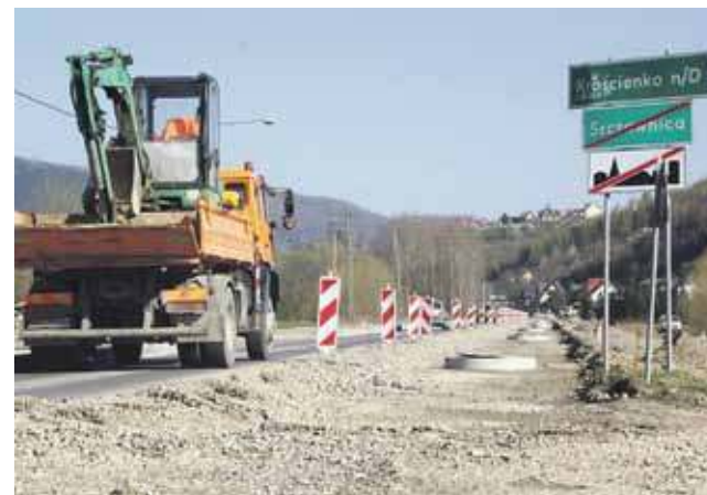
Przebudowa drogi Krościenko-Szczawnica trwa w najlepsze.
