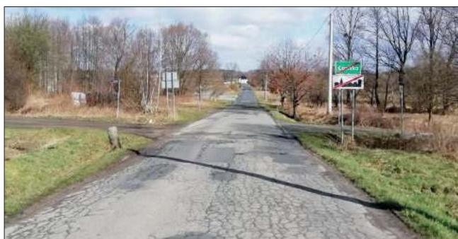
Od tego miejsca zostanie przebudowana ul. Dworcowa. Dwa lata temu przebudowano wcześniejszy odcinek Dworcowej/Wodzisławskiej na pograniczu Łazisk i Turzy
