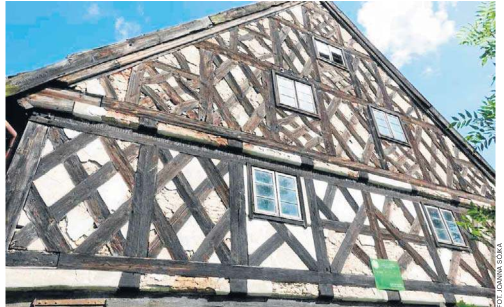
Dom ze Stalewa to konstrukcja typowa dla architektury Żuław - z murowanym przyziemem i szkieletową górną kondygnacją
