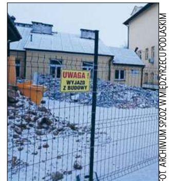
Wejście na teren szpitala możliwe jest od ul. Staromiejskiej i Warszawskiej
