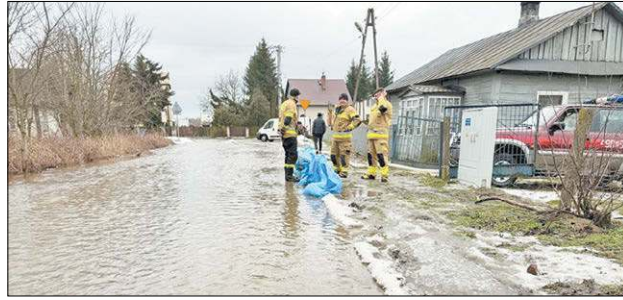
W powiecie parczewskim w niektórych miejscach do ograniczenia i usunięcia zagrożenia użyto worków z piaskiem i pompy dużej wydajności
