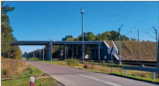
Przy wiadukcie powstaną zjazdy, zakończenie inwestycji przewidziane jest na październik 2027 r.
