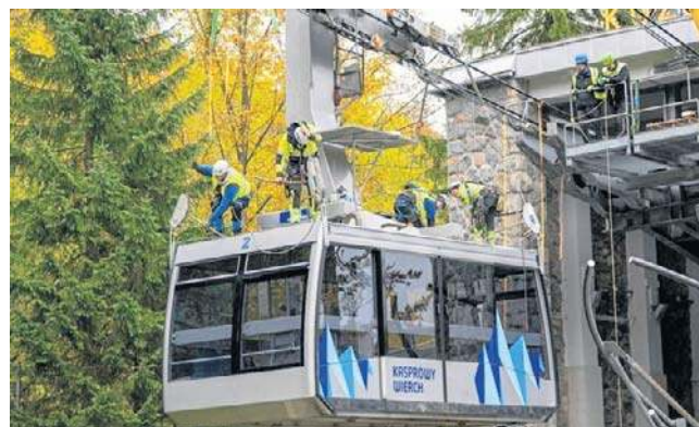
Demontaż wagonów kolejki na Kasprowy Wierch w Tatrach
